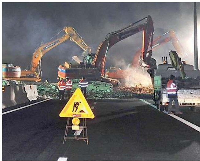
Un cantiere sull'A4 per la terza corsia in una foto d'archivio
